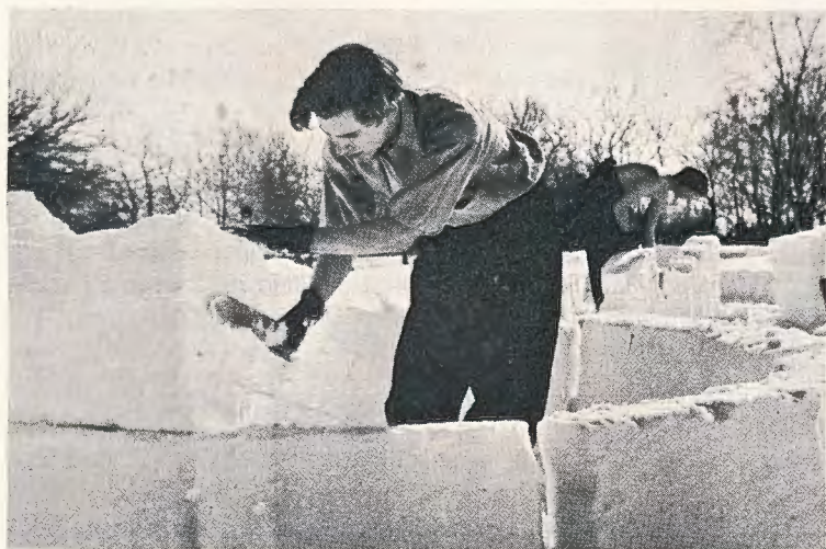
Snekniven i Anvendelse for at jævne Endeflader til, inden den næste Blok anbringes.
