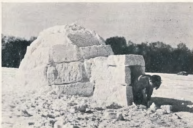
Indgangen à la Jættestue er bygget. Nu mangler der kun at »kitte« Revnerne og kaste hele Huset til med løs Sne, saa at Kubefaconen ændres til en Keglestub.
