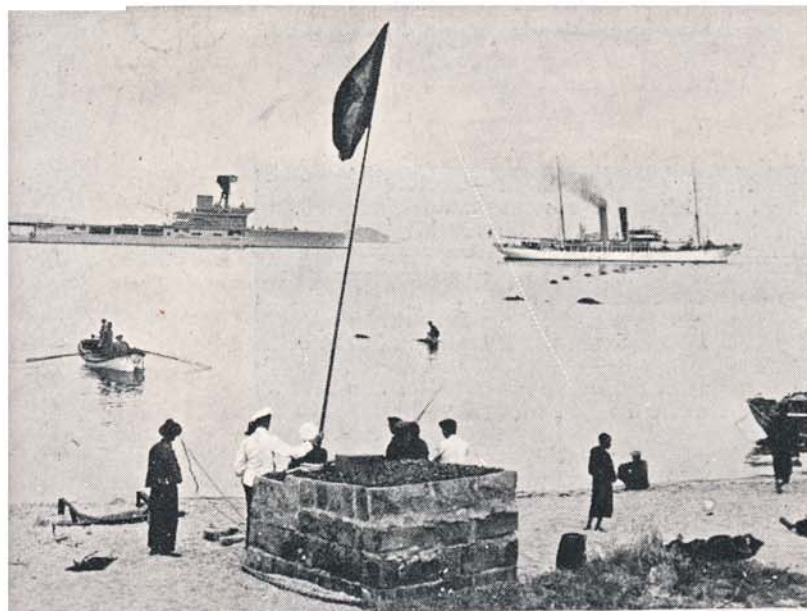
Store Nordiske Telegrafsekskab. Kabel bringes i Land fra Kabeldamper i de østasiatiske Farvande.
