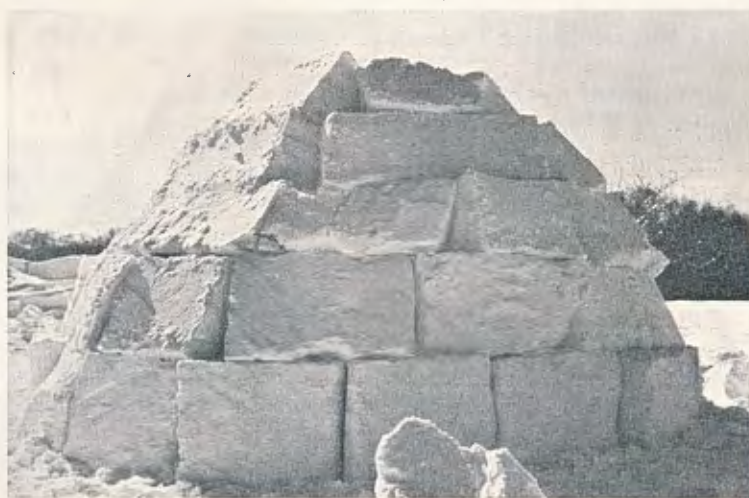
Bygmesteren har muret sig inde og vil nu skære sig ud inde fra, dér hvor Indgangen skal bygges i Læsidan.
