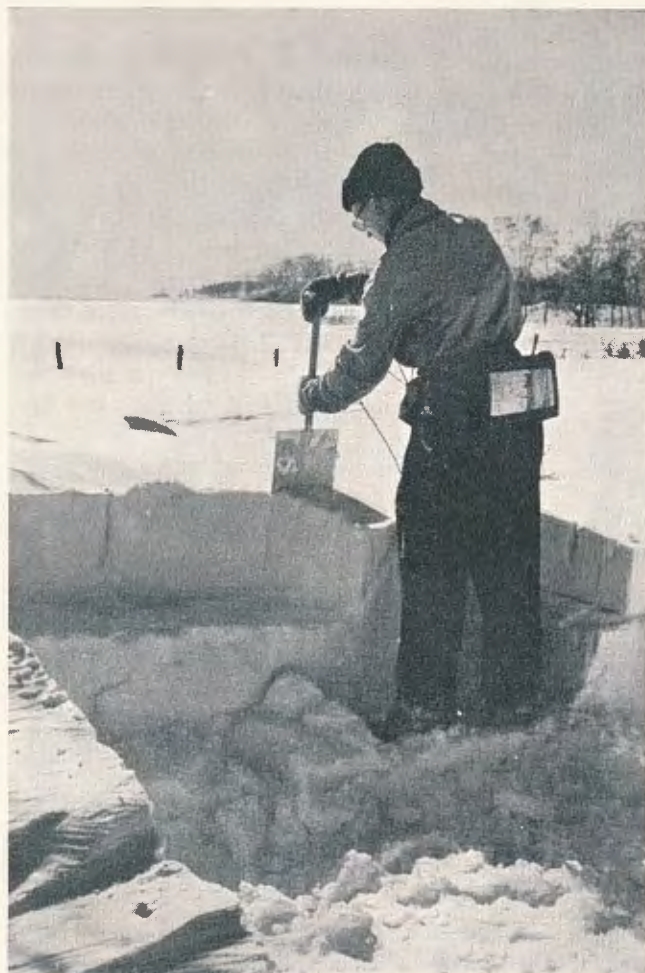
Bloksneen skæres ud med en dertil konstrueret Snespade: et Stykke plant Dur-aluminium uden Følser paa et Skaft.
