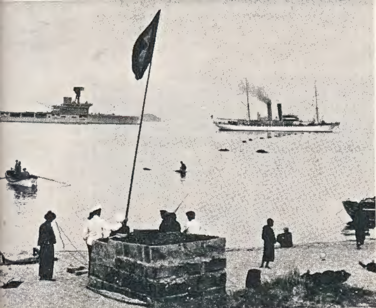
Store Nordiske Telegrafelskab. Kabel bringes i Land fra Kabeldamper i de østasiatiske Farvande.
