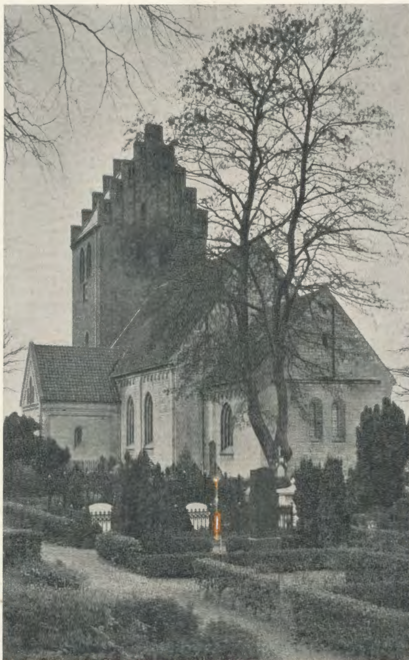
Fig. 4. Brønshøj Kirke. Kor og Skib fra 12. Aarh. Læg Mærke til de romanske Vinduer i Østgavlen og de gotiske Vinduer paa Sydsiden.
