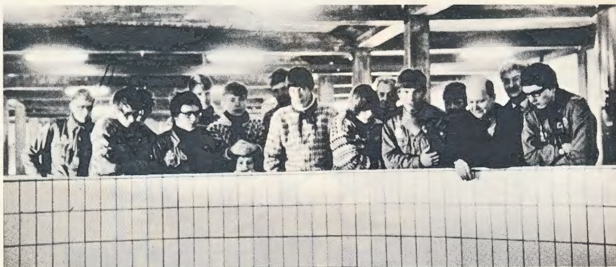
Omkring samlebrønden i rensningshallen på Regnemarkværket
